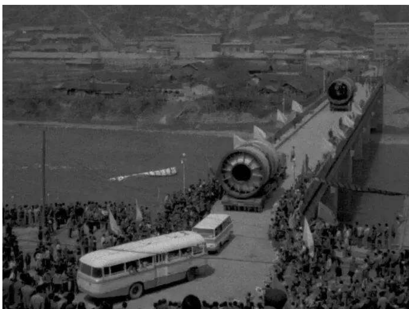
航空发动机高空模拟试验基地旧址
