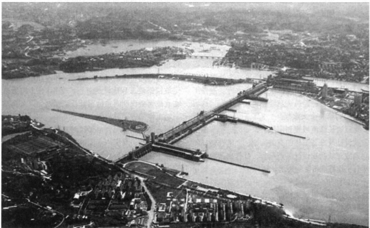
葛洲坝水利枢纽工程鸟瞰图
