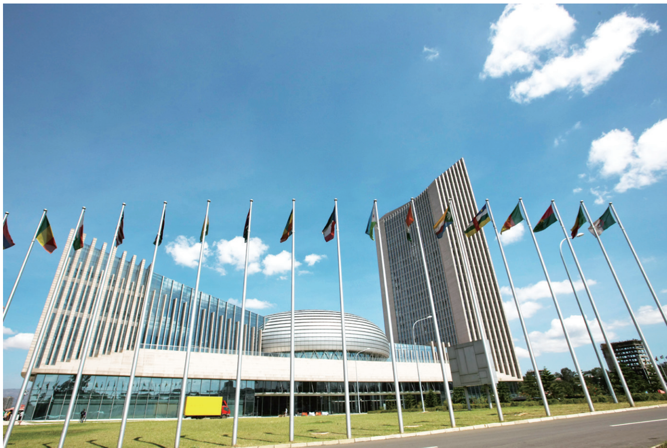
非盟会议中心项目是中国援助非洲重点项目之一，也是中国政府继坦赞铁路后对非洲最大的援建项目。图为位于埃塞俄比亚首都亚的斯亚贝巴的非盟会议中心及综合办公大楼。
